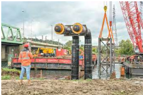
Les travaux d'extension en cours
